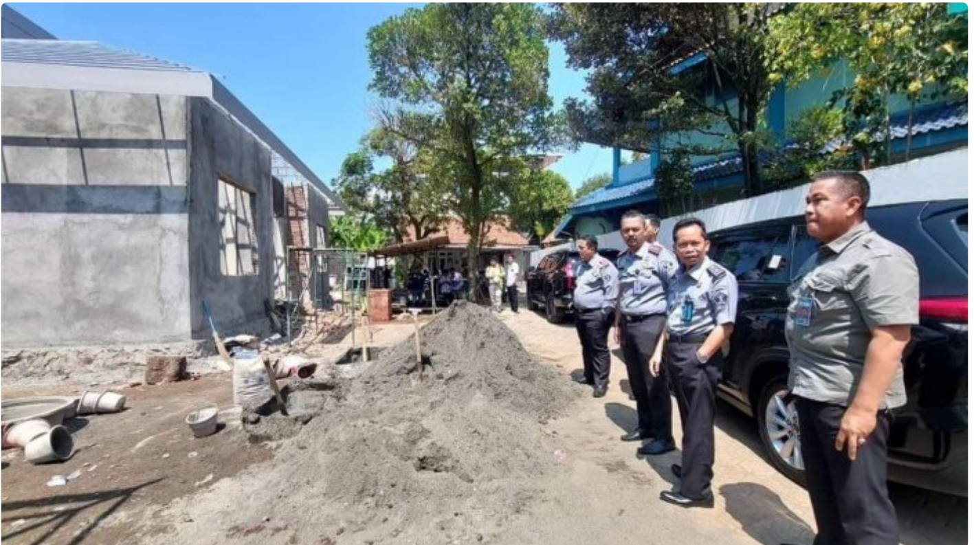
Kadivmin Kemenkumham Jateng Hajrianor Pantau Progres Pembangunan dan Renovasi Rumah Dinas Kanim Kelas I TPI Cilacap
